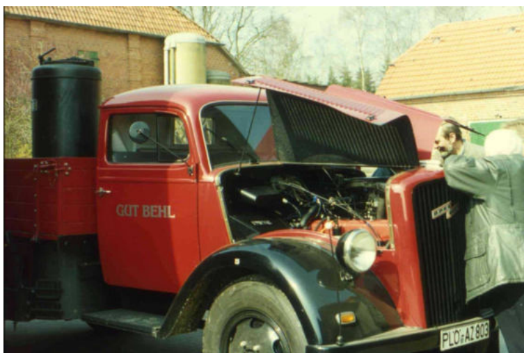
Abb. 1: Imbert-Gasgenerator auf restauriertem Opel Blitz (1985)
