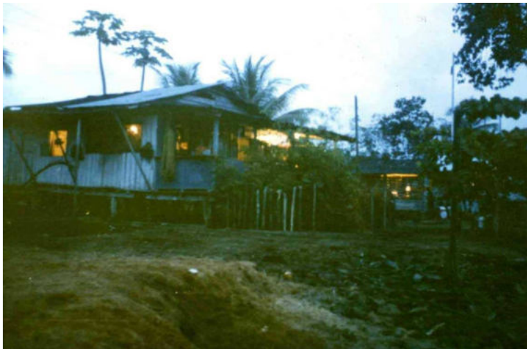
Abb. 6: Stromversorgung des Gemeindehauses in St. Cruz (Kolumbien) durch einen Holzkohlevergaser (1990)
